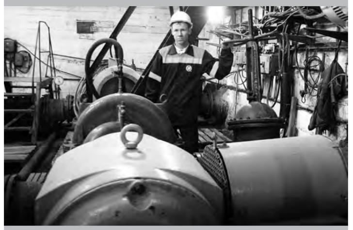
Сегодняшняя задача О.Г. Сивкова, слесаря по ремонту оборудования сетей, – ревизия насосов водооборотной станции
