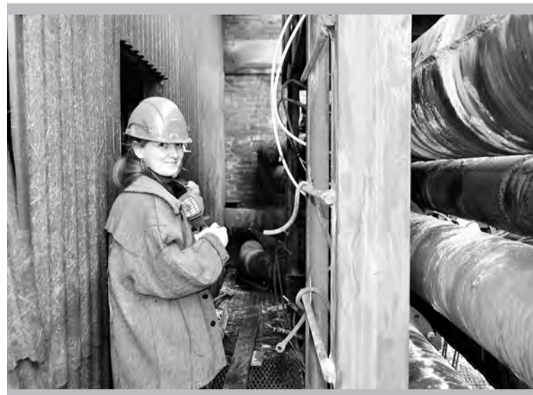
Девушки-киповцы цеха № 16 — тоже участницы ремонта
