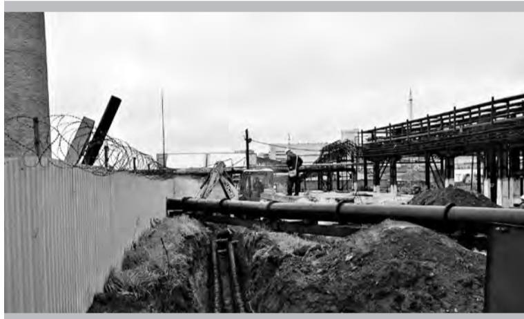
Врезка участка водовода возле склада хлора цеха № 4
