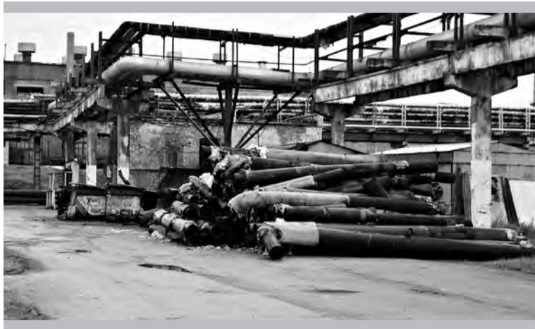
Старые трубы (вот их сколько заменили!) – в металлолом!
