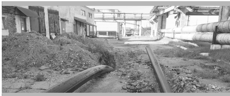
Замена трубопроводов по-новому: полиэтиленовая труба просто «заползает» под землю...
