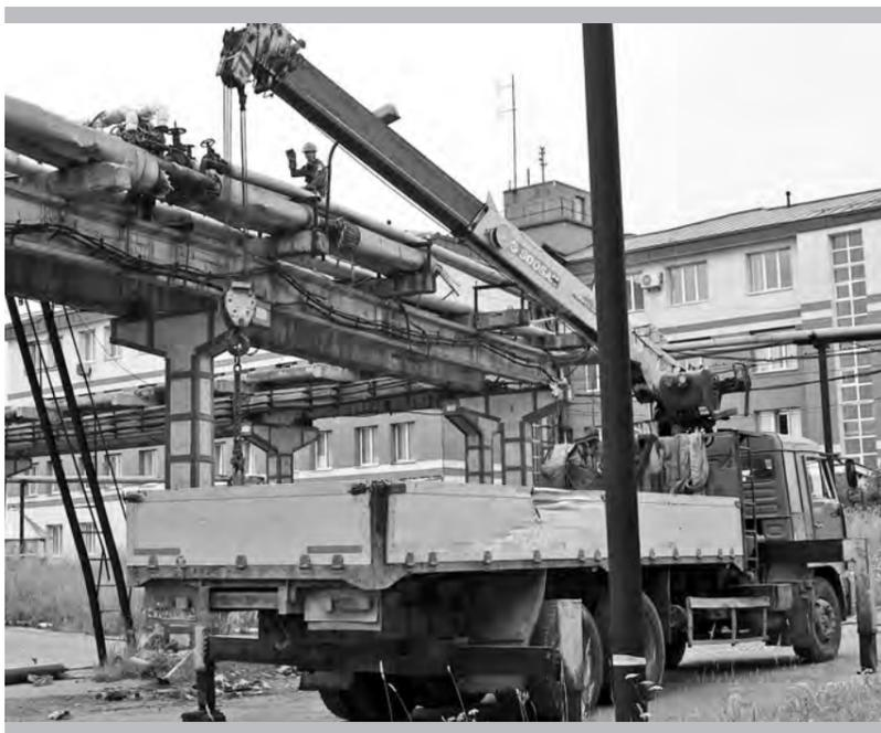
Начались работы по ремонту и ревизии систем отопления и водопроводов артезианской и горячей воды в здании гипохлоритной пульпы.
