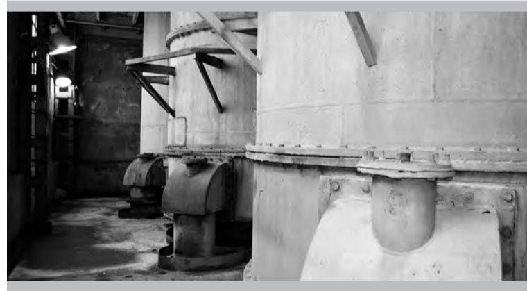
В хлорной компрессорной цеха № 4
