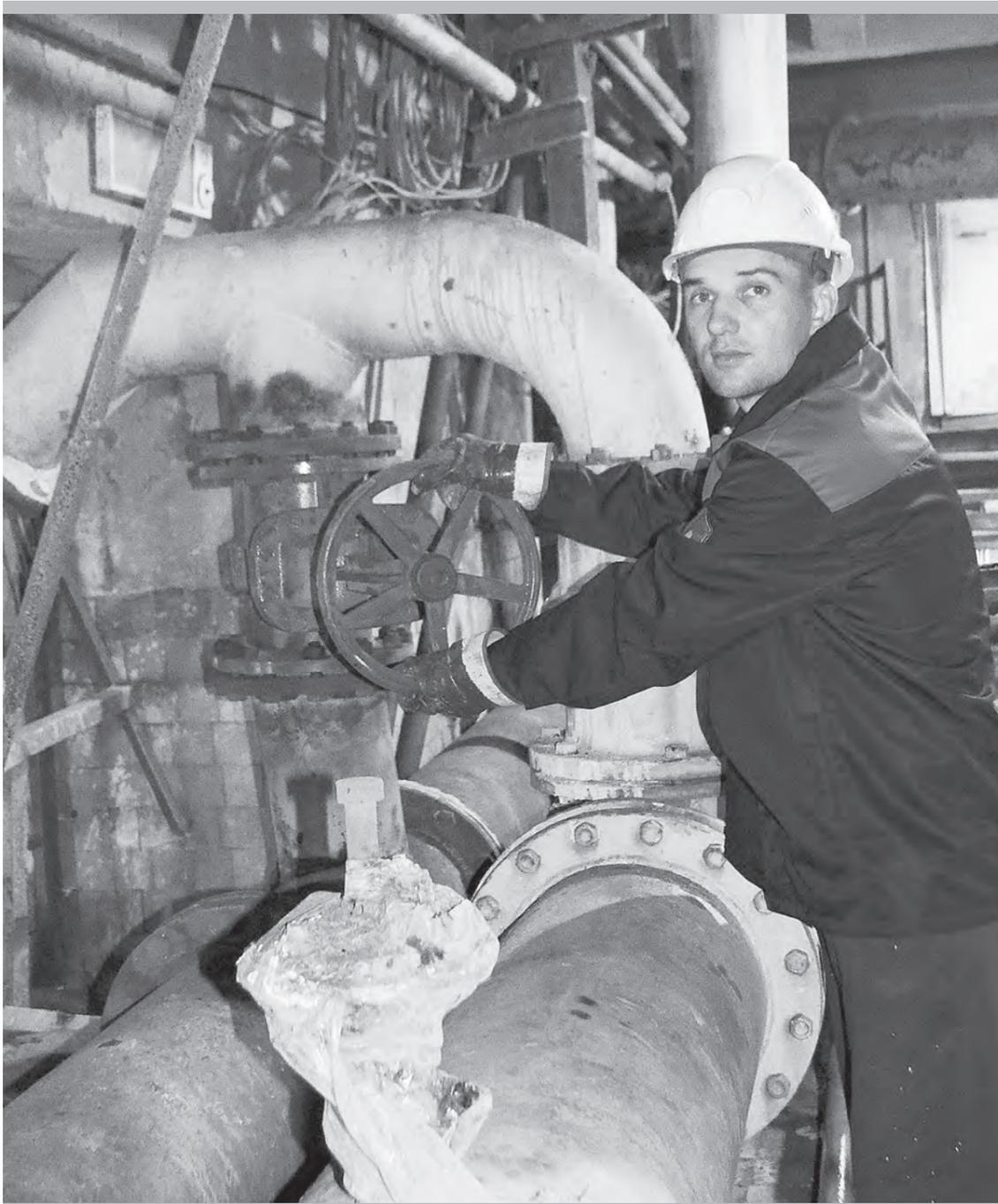
Этот участок напорного коллектора, отвечающего за распределение анодного хлор-газа в хлорной компрессорной завода, только-только вступает в работу после капитального ремонта (точнее – полного обновления). Как производится регулировка давления в процессе подачи газа, показывает Р.С. Морозов, исполняющий обязанности бригадира дневной бригады подразделения. Все подробности капремонта – на нашей второй полосе.
