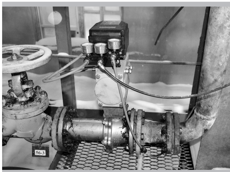
Новые регулирующие клапаны уже несут свою службу на третьей (рабочей) системе станции сжижения
