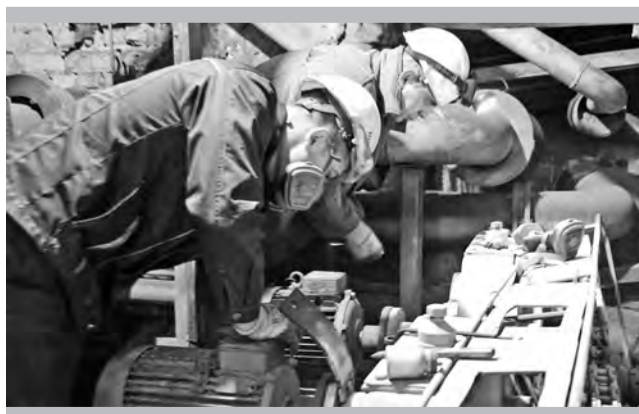
Установку двигателя ведут электрики цеха
