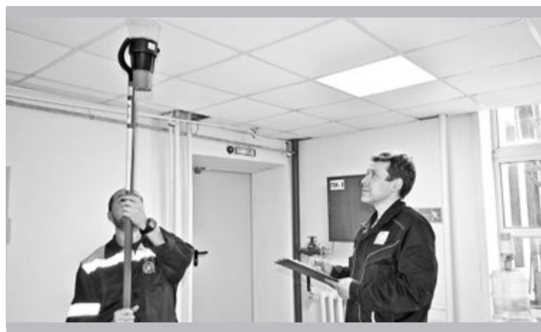
Заводские связисты: очередная проверка пожарной сигнализации
