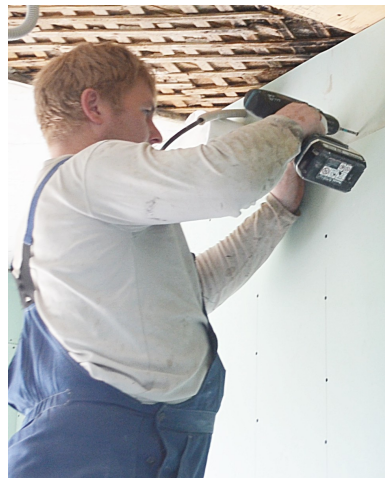
Ведутся работы и на третьем этаже
