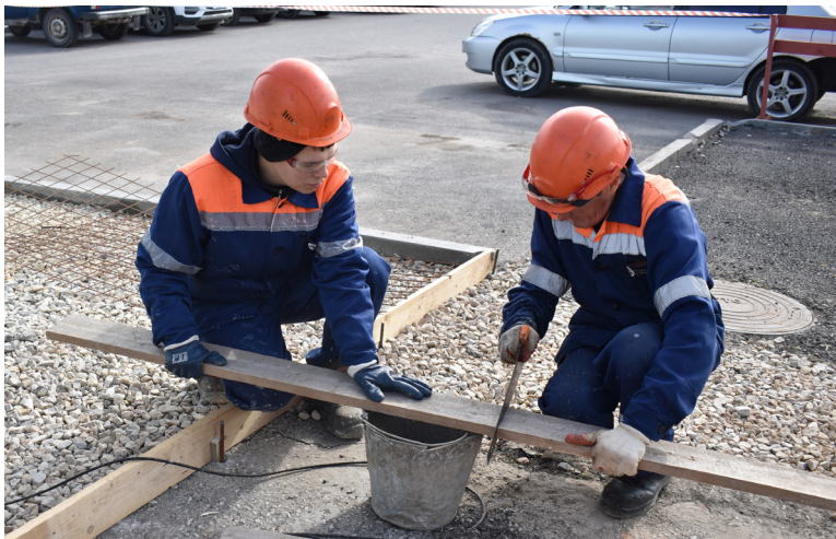
Монтаж откоски выполняют плотники цеха № 26 Павел Антропов и Виктор Сабуров
