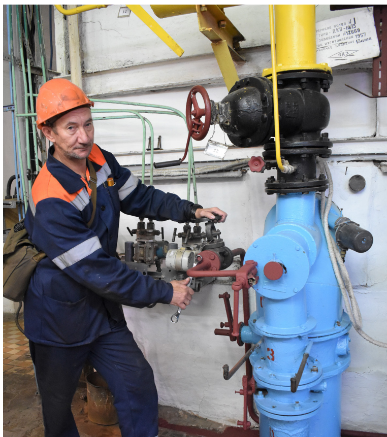
На ремонте парового котла № 1 – огнеупорщик Виталий Стариков
