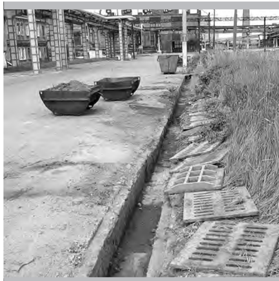
Цех № 1 начал ремонт ливневой канализации
